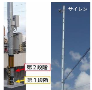
【図3 浸水警報装置】 出典「岡崎市水害対応ガイドブック」
