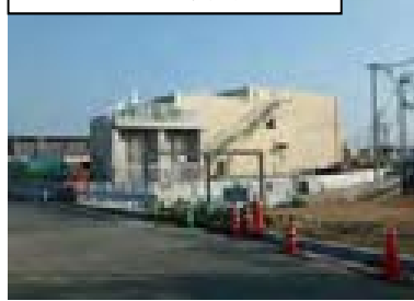
間の川ポンプ場建設状況
