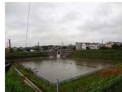
流入時の新東谷調整池
