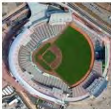
大州雨水貯留池 上部利用
