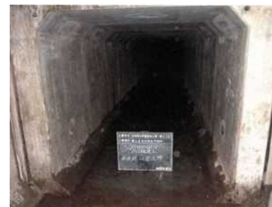
国道463号アンダー部 (BOX1600×1600)
