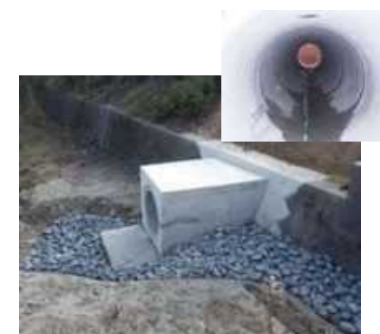
川池バイパス水路 (直径1.0~1.2m、延長0.5km) (平成30年度供用開始)
