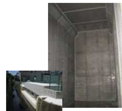
川池ちびっ子広場調整池 (貯留量:600㎡) (平成29年度供用開始)
