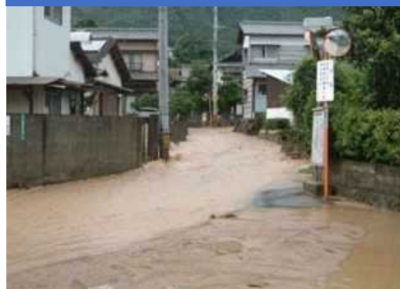
平成15年被害状況
