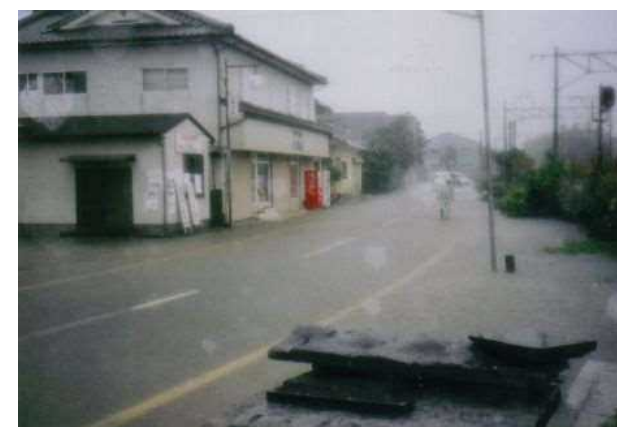
浸水被害状況(柴引・麓地区) H18.7月
