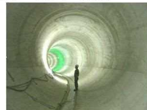
中央雨水1号貯留幹線 【直径:5.25m 延長:5.1km 貯留量:約8万m 3 】
