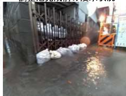
調整池完成前の浸水状況
