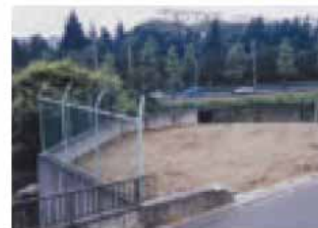
埋め立て後の状況
