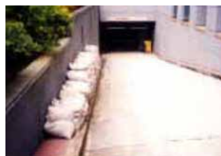
土嚢の設置事例
