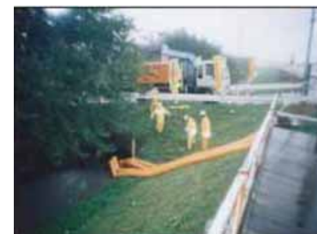
可搬式ポンプによる排水
